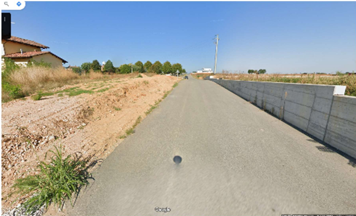
Vista della nuova area di circolazione, da est verso ovest ossia da via Sopra Costa verso via Salmour (riproduzione da Google Street View)
