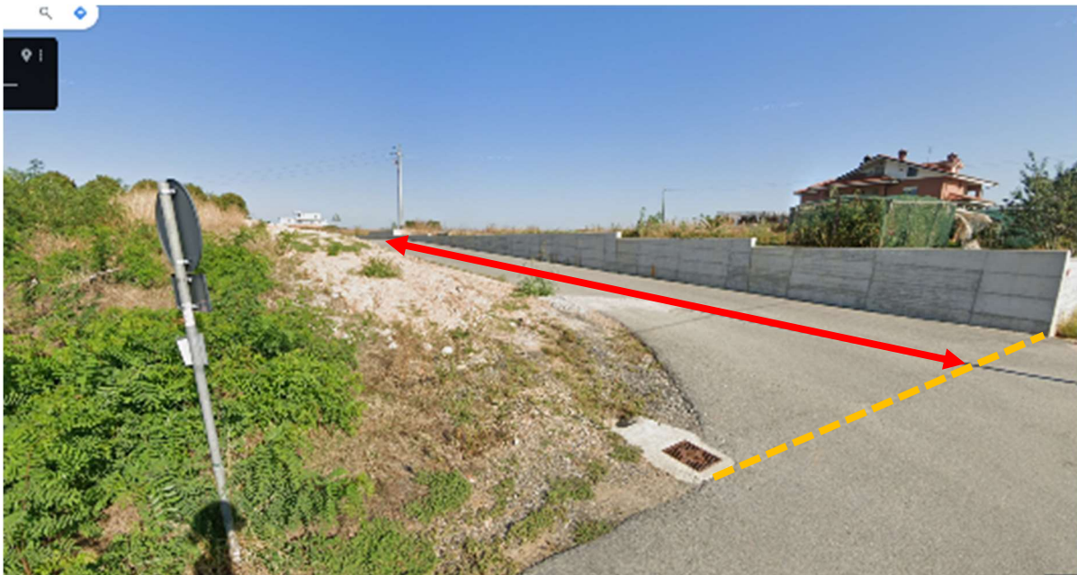
Punto di inizio, ad est, di Via Gualino all'incrocio con via Sopra Costa (riproduzione da Google Street View)
